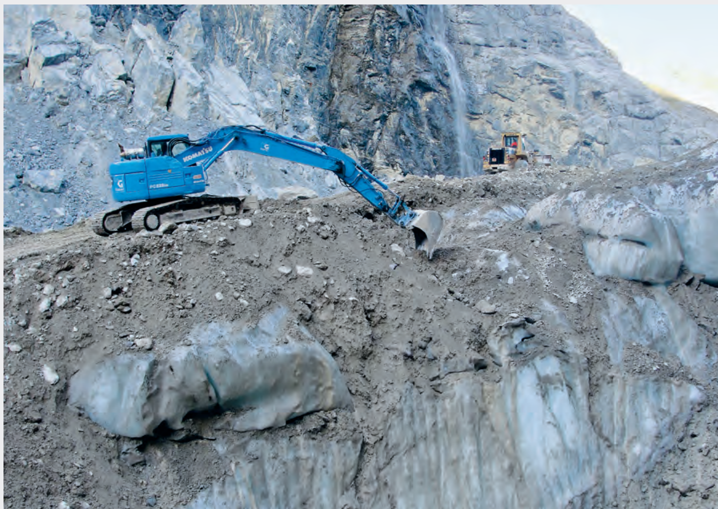
Bauarbeiten auf dem Unteren Grindelwaldgletscher (Kanton Bern) am 7. Oktober 2009: Der Gletscher hat sich in den letzten 150 Jahren stark zurückgezogen. Auf seiner Oberfläche bildete sich 2005 erstmals ein See. Um die Gefahr eines Gletscherseeausbruchs zu bannen, wurde 2009 ein Entwässerungstollen gebaut.
